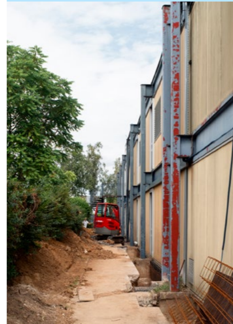
Le projet a demandé une reprise des fondations.
