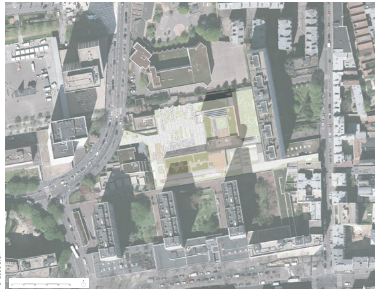
Cette réhabilitation s'inscrit dans le tissu urbain de la place des Fêtes à Paris
