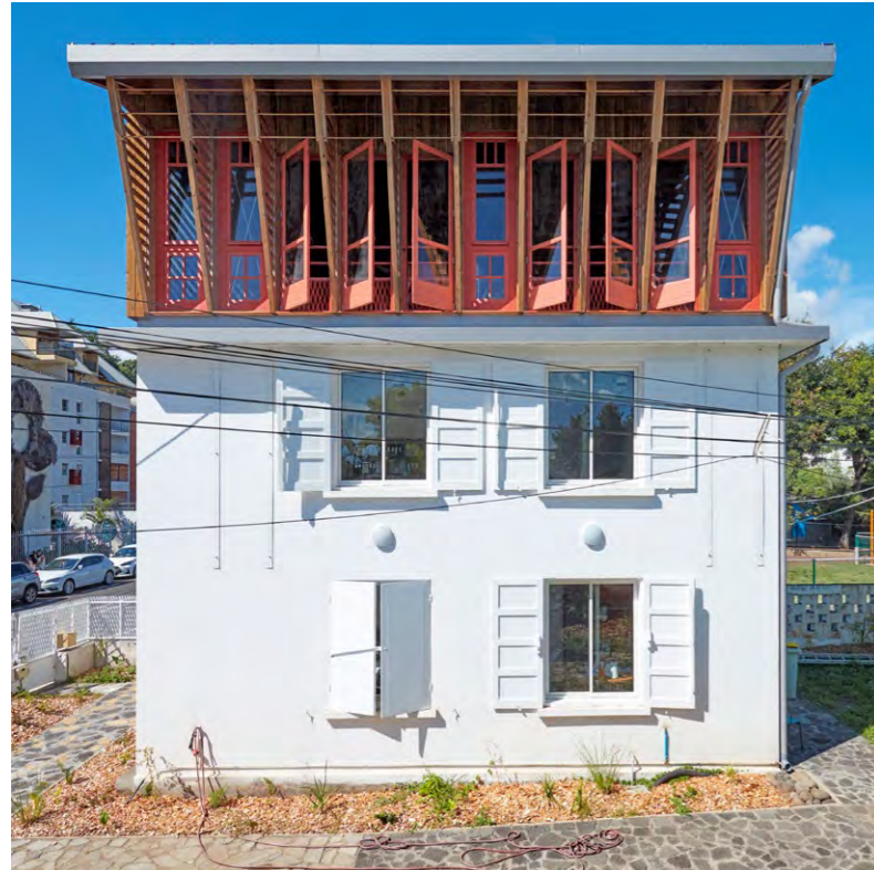
Une surélévation en bois a été posée sur une ancienne « case béton » réhabilitée.
