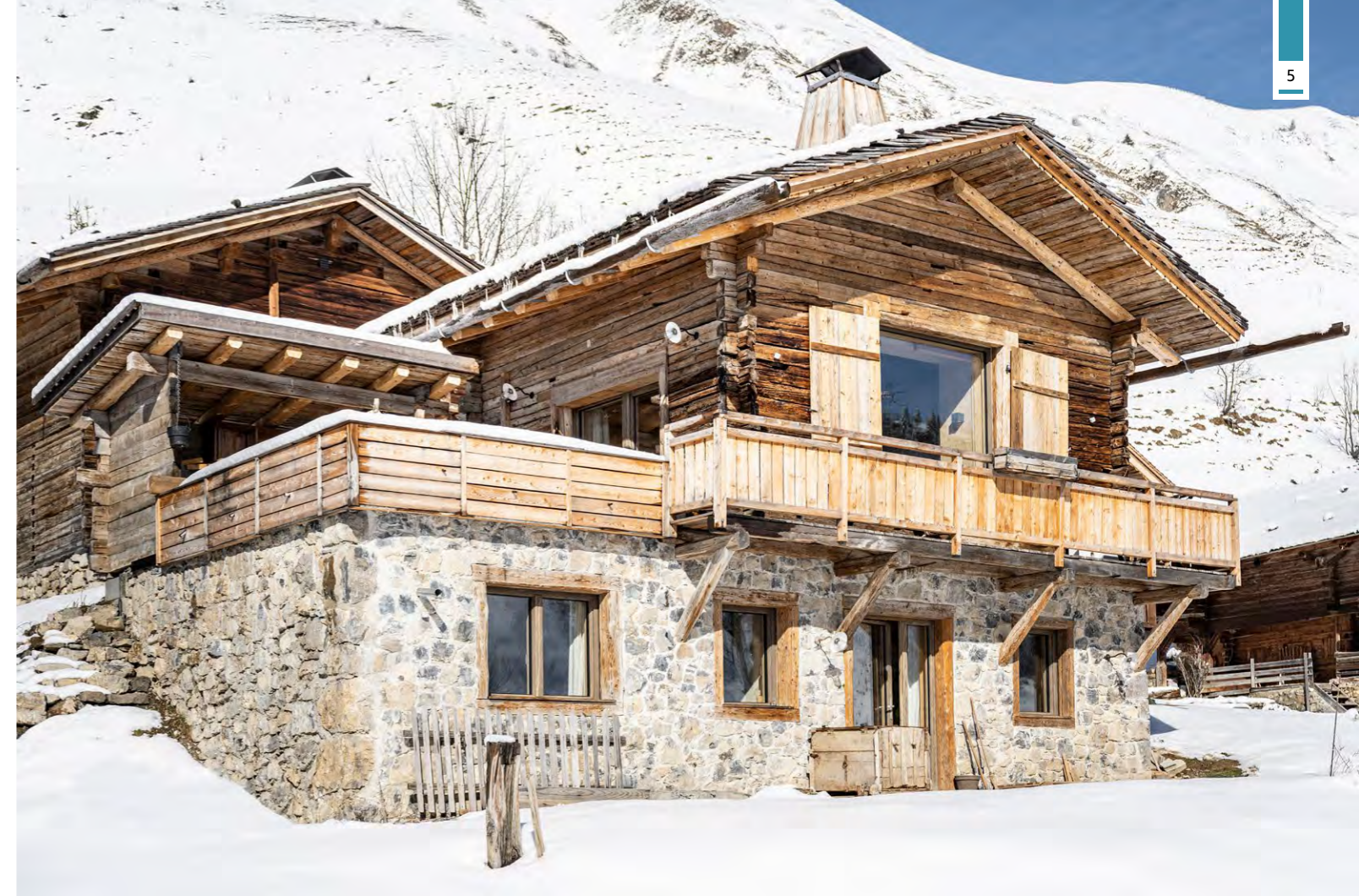
Cette réhabilitation exemplaire pourrait inspirer les propriétaires d'autres mazots d'alpage en ruines.
