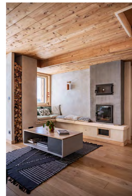
Deux heures de feu dans le poêle de masse suffisent au confort thermique pendant une journée.
