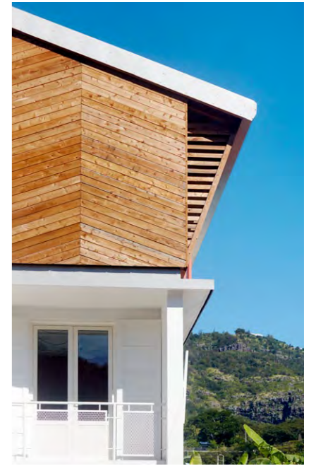
Le bardage sur la façade est en cryptomeria local.
