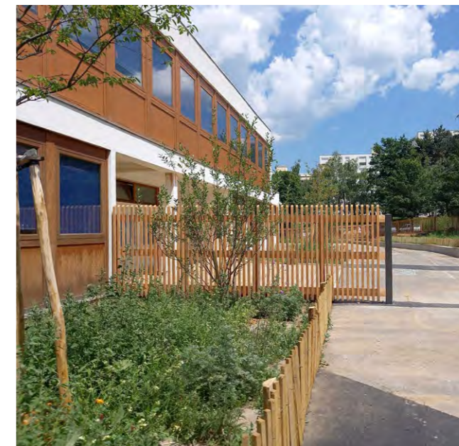
Depuis l'entrée, on voit le portail réalisé avec les services techniques, l'enrobé conservé et la noue végétalisée.
