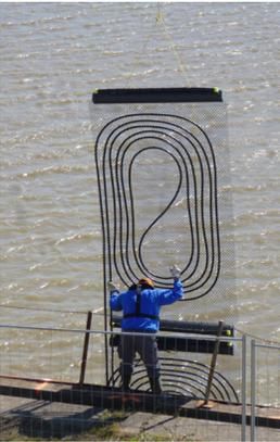
La Loire constitue un réservoir d'énergie naturelle et renouvelable. En effet grâce à sa forte inertie de température, celle-ci ne descend pas en dessous de 3°C en hiver. Par l'intermédiaire de 32 modules de captages géothermiques et une pompe à chaleur réversible, la Loire assure les besoins en chaud et en froid du bâtiment.
