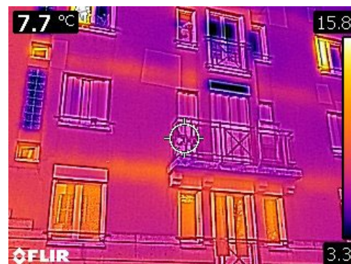
Thermographie façade sud bâtiment Holweck
