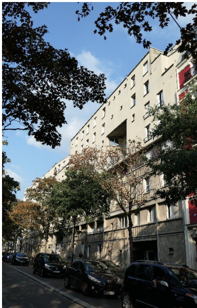
Rue Vercingétorix : la façade se compose d'un registre inférieur en béton brut et céramique, et d'un registre supérieur en enduit blanc
