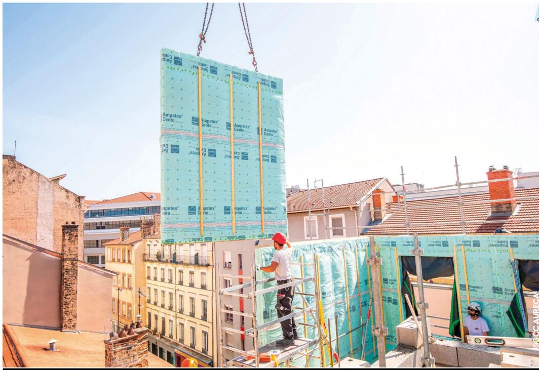
La préconstruction des panneaux hors site permet un assemblage rapide réduisant au maximum les nuisances du chantier.
