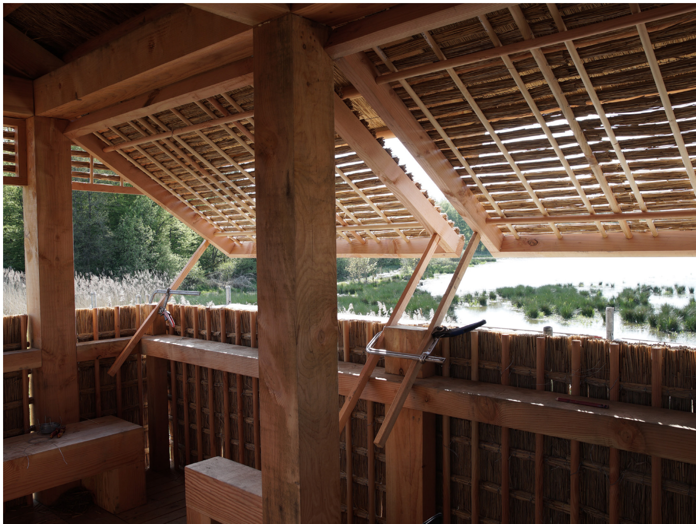
photo en cours de chantier
