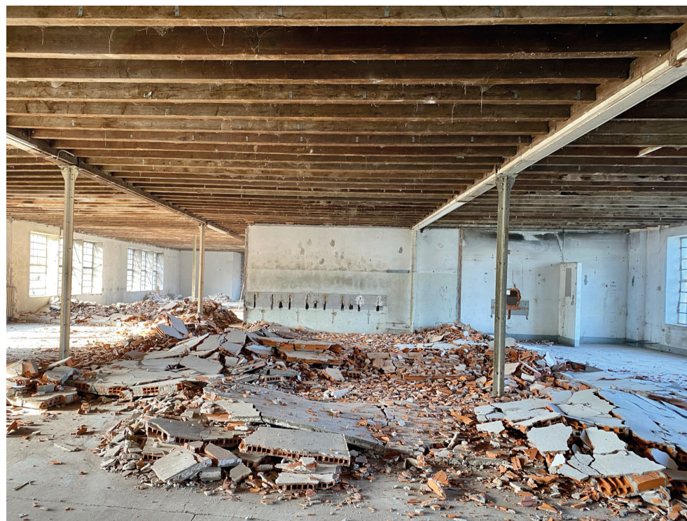
Curage du bâtiment, mise à nu des structures
