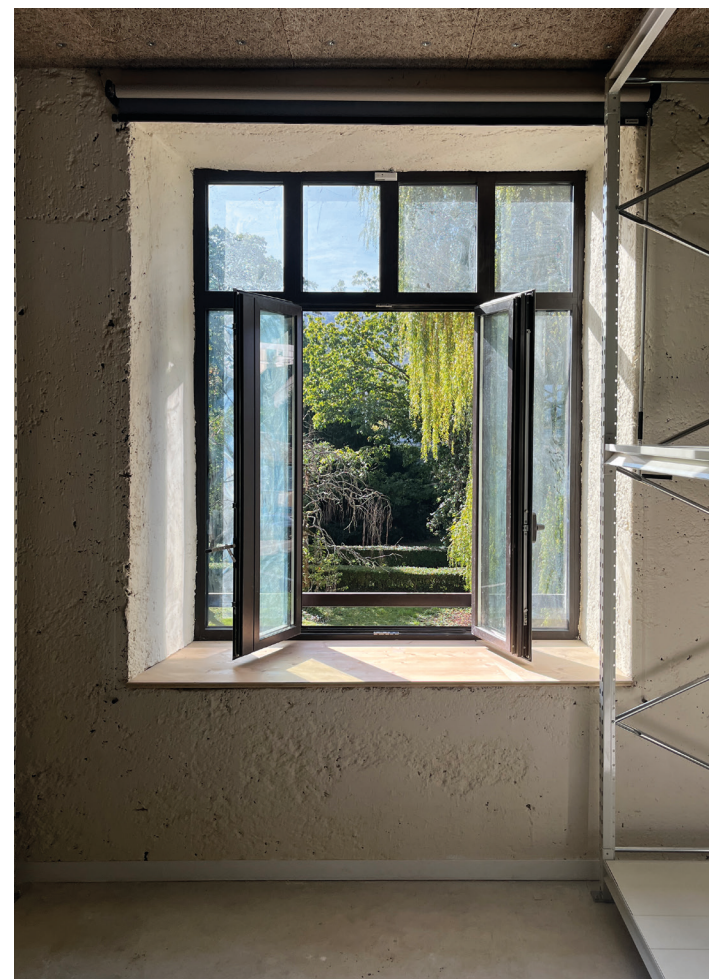
Doublage intérieur en béton de chanvre avec finition lait de chaux
