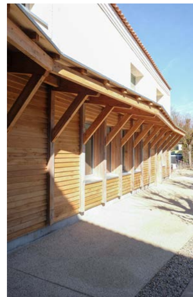
Bardage Chêne et structure Douglas
