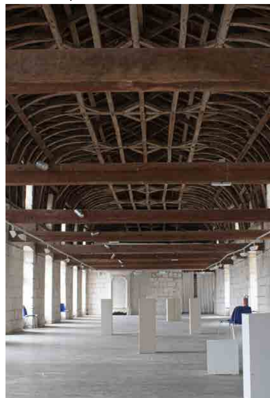
Charpente de l'abbaye - salle des moines
