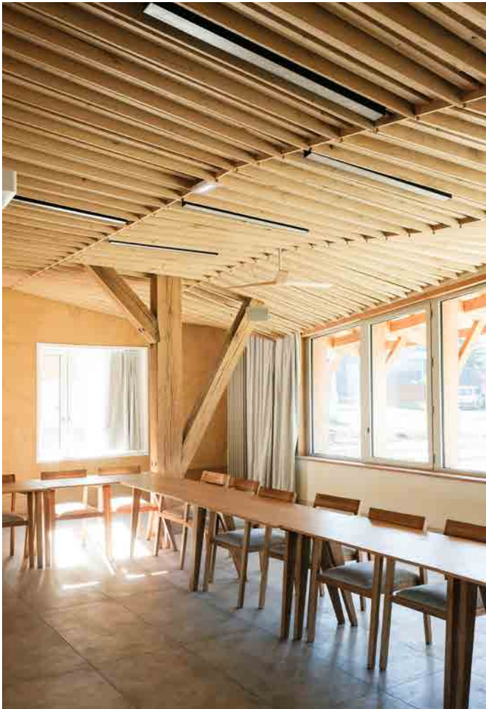
Mise en oeuvre du bois dans la salle du conseil (faux plafond, structure et mobilier)
