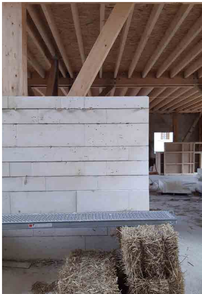
Mise en oeuvre des cloisons pierre sur site
