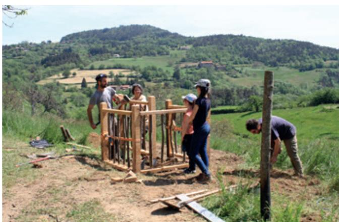
*Construction de passe-cloture en châtaigner pour traverser le près des vaches*
