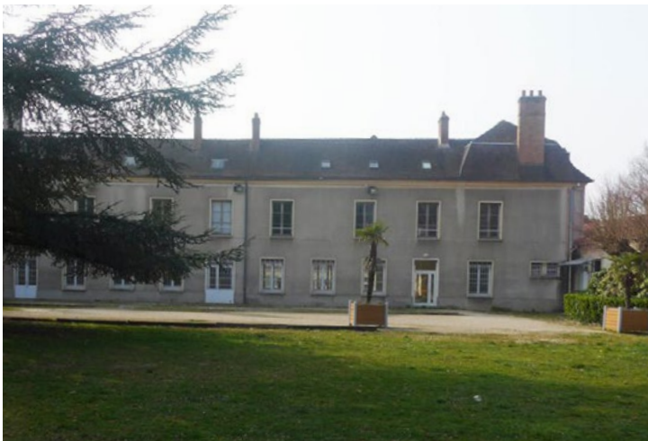
1 - La bibliothèque (RDC) et l'hôtel d'associations (à l'étage) sont situés dans l'aile droite des écuries de l'ancien château d'Arpajon
