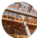
Structure et système d'assemblage ajustable et démontable, pour permettre au bâtiment lui-même de rentrer dans cette logique de réemploi.
