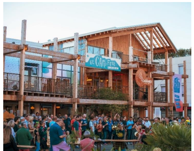
Façade ludique principale : arborant une ossature en bois ouverte sur la ville, elle se présente comme une « étagère urbaine ».
