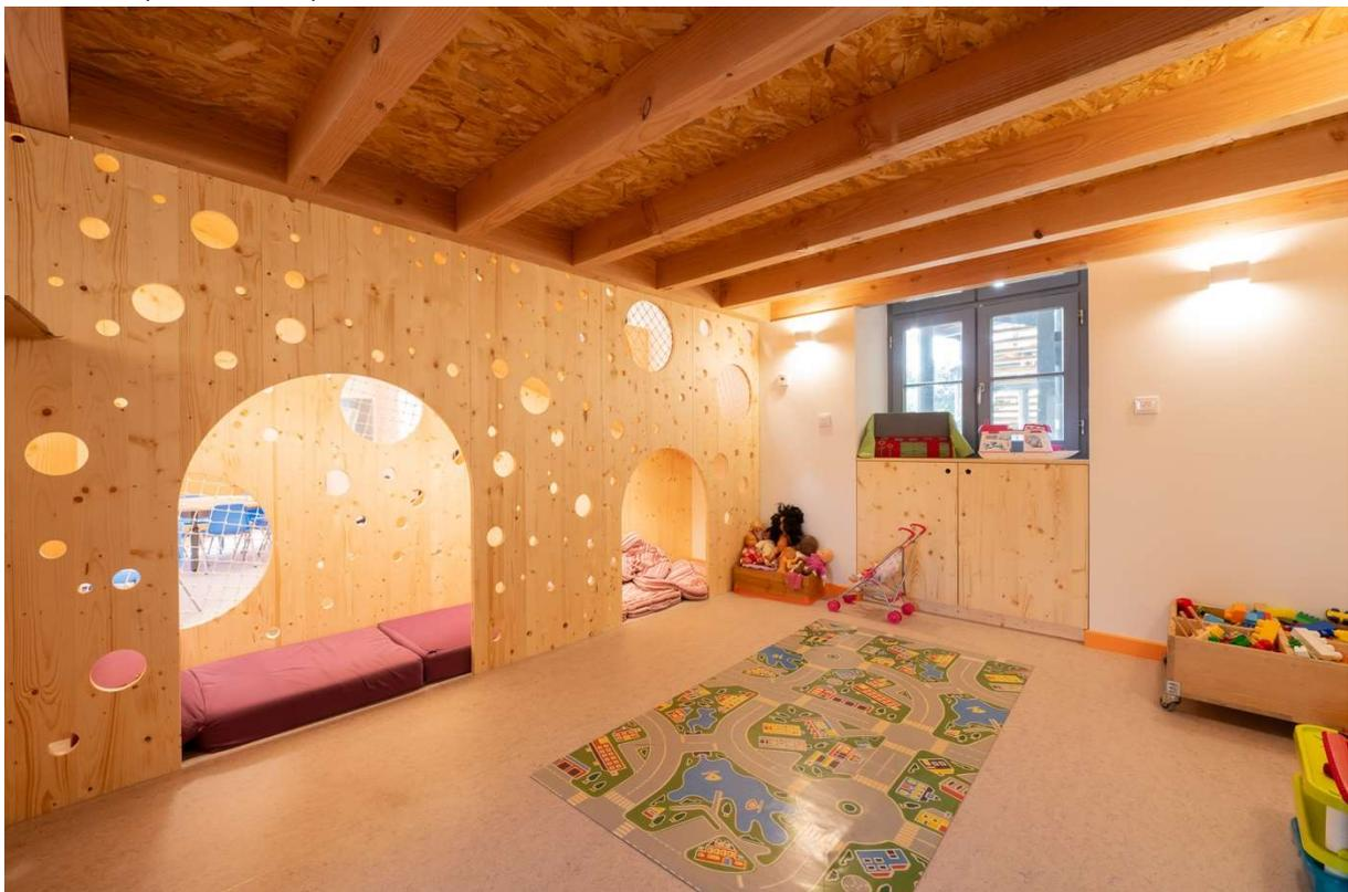
Les espaces intérieurs utilisent le volume existant dans les 3 dimensions. L'ancien faux-plafond de l'étage a fait place à un volume sous rampant et des mezzanines ont été créées à chaque niveau. La réintégration dans les surfaces utiles de l'ancienne cage d'escalier qui occupait 1/3 de la surface a permis de créer bureau de direction, tisanerie du personnel, WC et rangement sans diminuer l'espace des deux salles.
