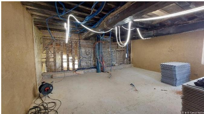
Les matériaux utilisés pour la restauration sont d'origine biosourcé : liège, dalle de chaux, carreau de travertin, enduit chaux-chaivre, enduit ou badigeon de chaux, laine de bois dans les pans de bois, panneaux de fibres-gypse, menuiseries bois, parquet bois.
