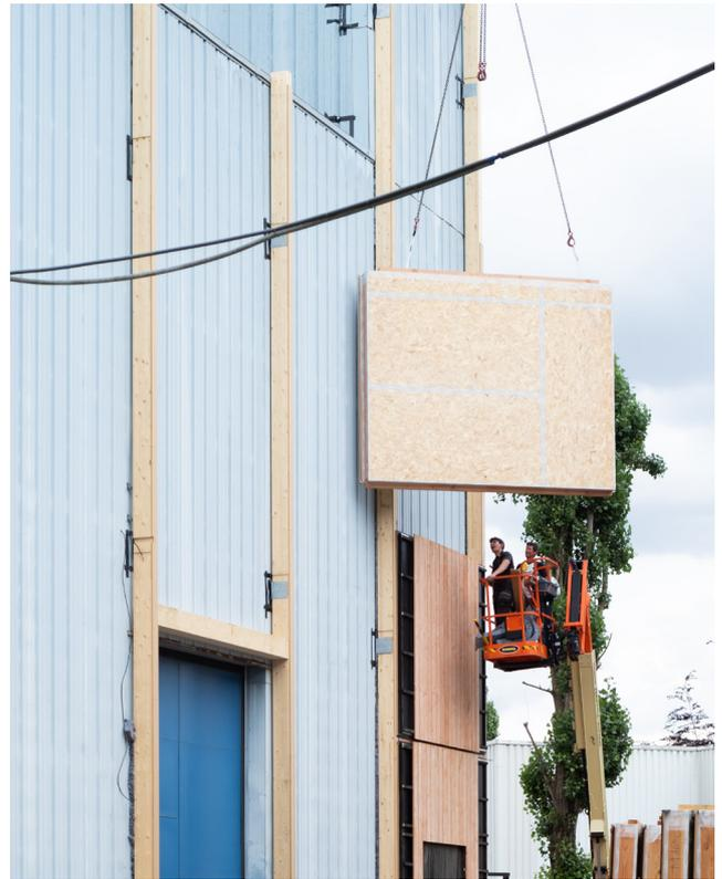
Mise en place des murs à ossature bois isolés en paille
