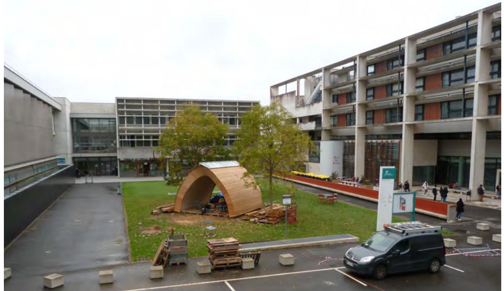
● ● ● Le projet exige des courbes, les bottes sont contraintes sur de petits gabarits dont quatre sont fabriqués, érigés sur des palettes, permettant de courber des bottes en forme de claveaux. Le cintre est obtenu par l'insertion d'une dizaine de planches de bois par bottes sur une de ses deux faces, appelé alors l'extrados. Cette face recevra quelques mois plus tard le bardage en bois. Elle s'oppose à l'intrados sur lequel la paille reste nue, prête à être enduite.
