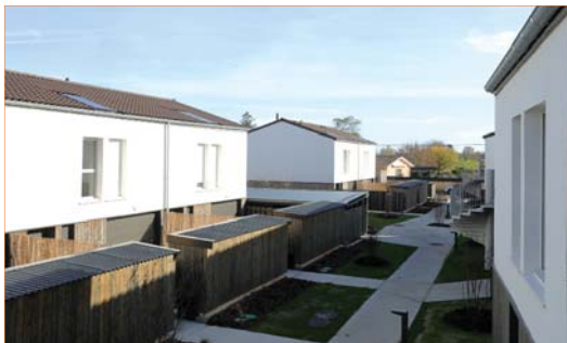
Les maisons en duplex vues depuis un palier desservant les logements semi-collectifs.
