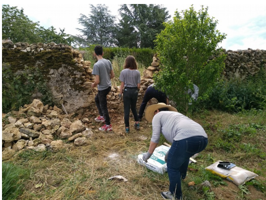
Réparation d'un mur écroulé dans le potager par les collégiens et anciens de Grivery – Juin 2020
