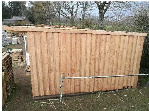
Dispositions identiques au 10 avril, l'avancée se mesure visuellement par les travaux de l'équipe de bardage qui commence à positionner les planches de recouvrement tout en ayant pris le soin de poser les grilles anti-rongeur sur les tasseaux du bas dans les coupes de ventilation.
