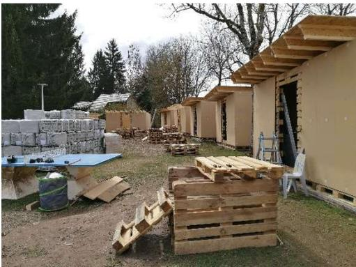
Après le contreventement des murs, pose du plafond pour permettre l'insufflation de l'isolant (ouate de cellulose en vrac).
