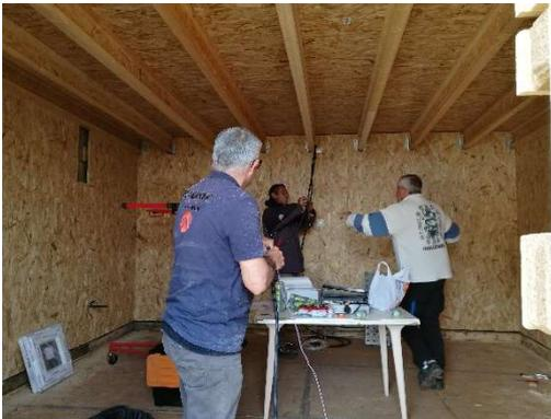
Agréable d'avoir un toit pour travailler, insertion des faisceaux et pose des boîtiers étanches pour les appareils électriques.
