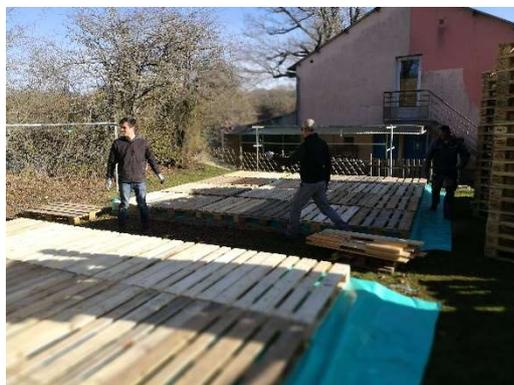
Mise en place d'un film d'étanchéité (anti termites) entre la dalle béton et les palettes de sol. Celles-ci assureront la ventilation sous la structure.
