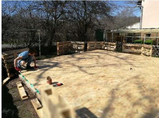
Pose de panneaux OSB 9mm pour lier la dalle et servir de sous face en vue de la pose de la couche d'isolation en ouate de cellulose pour le plancher.
