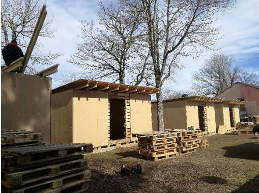
Préparation des coupes et ventilation des poutres en I (type Hi 220 à âme OSB) dans l'ensemble des structures.
