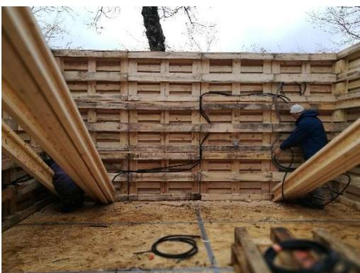
Mise en place d'un binôme pour la pose du réseau électrique dans les palettes de sorte qu'elle soit encastrée.
