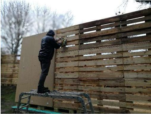
Pose et fixation de l'isolation extérieure, composée de laine de bois compressé en dalles bouvetées (rainure/languette).
