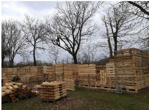
Élévation des murs par assemblage de palettes et de lisses Sylcat® successives.
