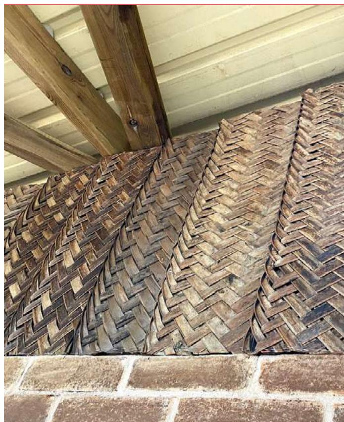
Mise en oeuvre de M'tsévé : matériau traditionnel mahorais réalisé avec des feuilles de coco tressées
