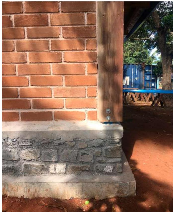
Soubassement en basalte, structure bois issue du réemploi et remplissage BTC avec essais de moucharabieh
