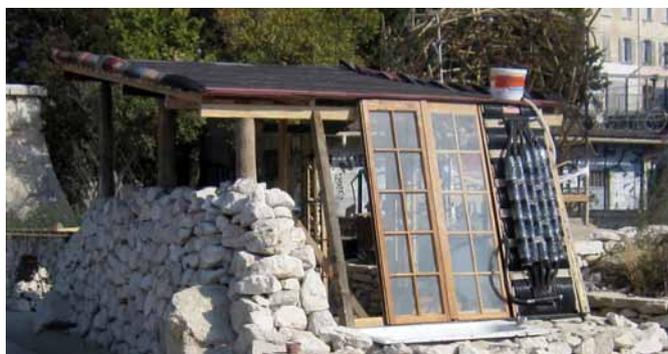
« maison solaire » chauffe-eau en bouteille à soda, toit en moquette.
