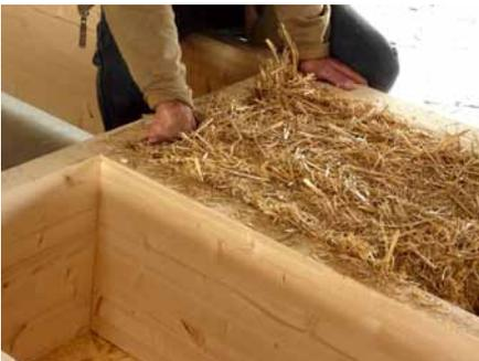
préfabrication mise en place du bloc de paille dans la structure bois
