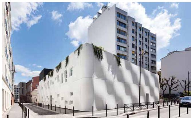
La façade blanche ondoyante, composée de panneaux autoportants préfabriqués minces ductal® et laine de roche, prouve que l'innovation par le biais d'un ATEX est possible à petite échelle. En contraste, le logement en superstructure est revêtu de mélèze brûlé.
