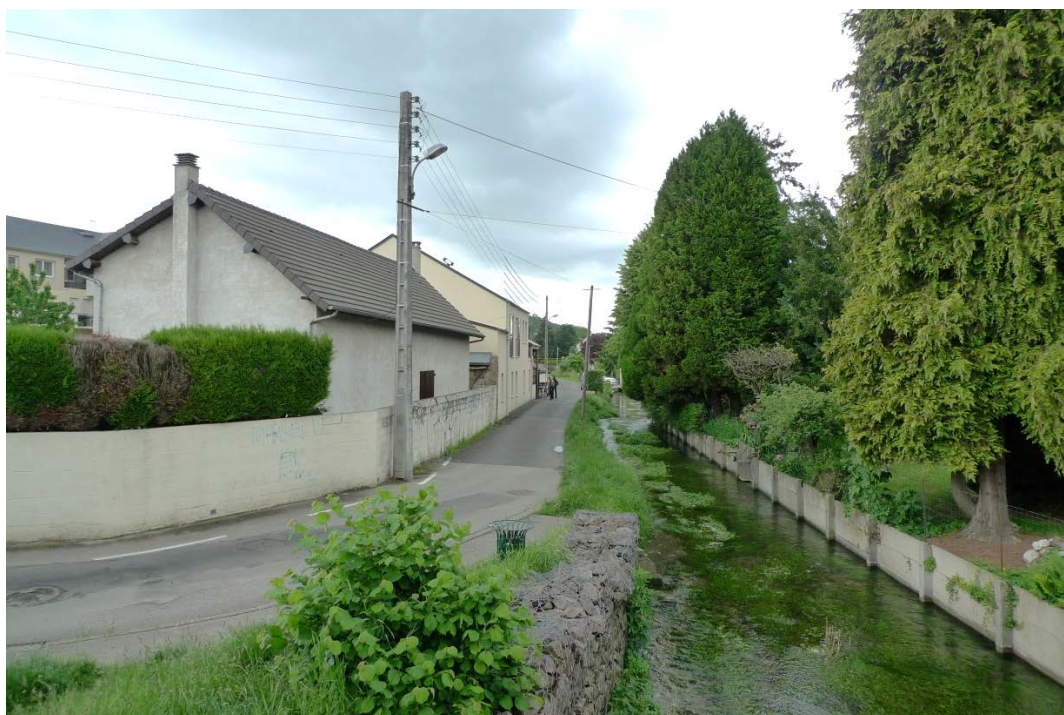
Le Gambon, cours d'eau traversant le quartier des planches aux Andelys
