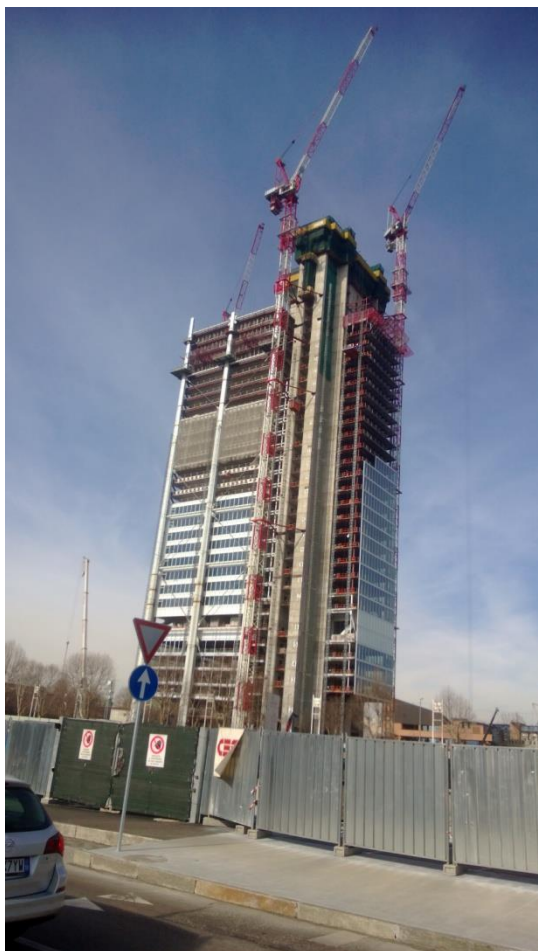
Chantier de la tour
