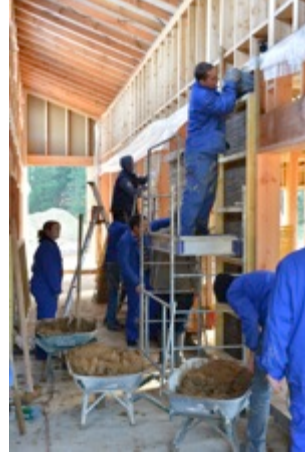
Photo 9 et 10 : remplissage des banches
