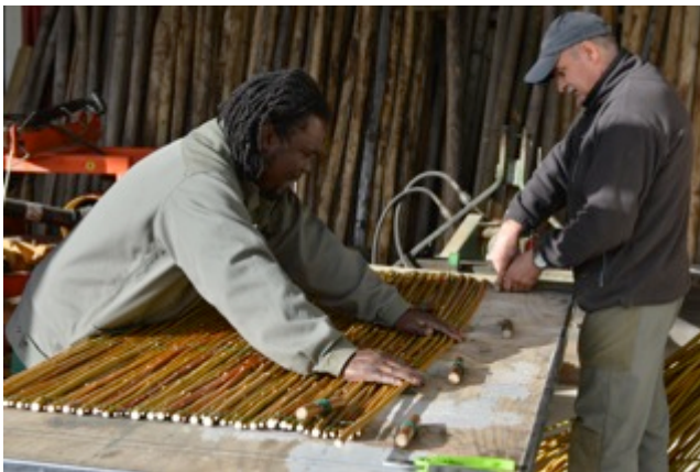
photo 5 : fabrication de l'armature en roseaux
