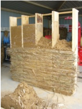
photo 3 : prototype mur en terre
