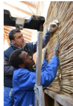
Photo 6 et 7 : mise en place des roseaux
