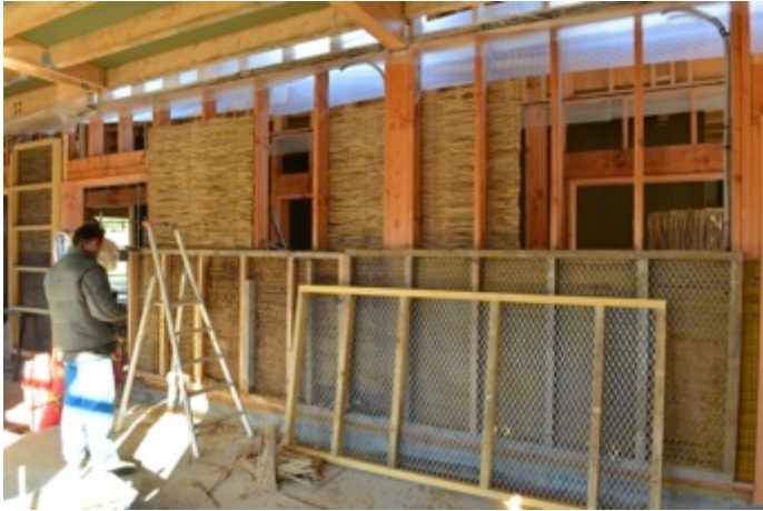
photo 6 : mise en place des banches
