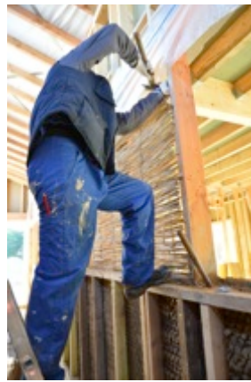
Photo 6 et 7 : mise en place des roseaux
