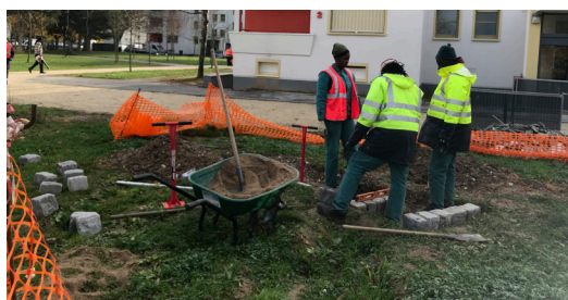
L'entreprise d'insertion Halage a réalisé la piste à vélo en bordures et pavés de réemploi
