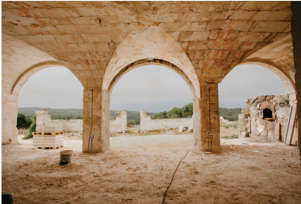
RESTAURATION DES VOUTES EXISTANTES DE LA FINCA, ANCIEN CORPS DE FERME, AU DÉBUT DU CHANTIER
