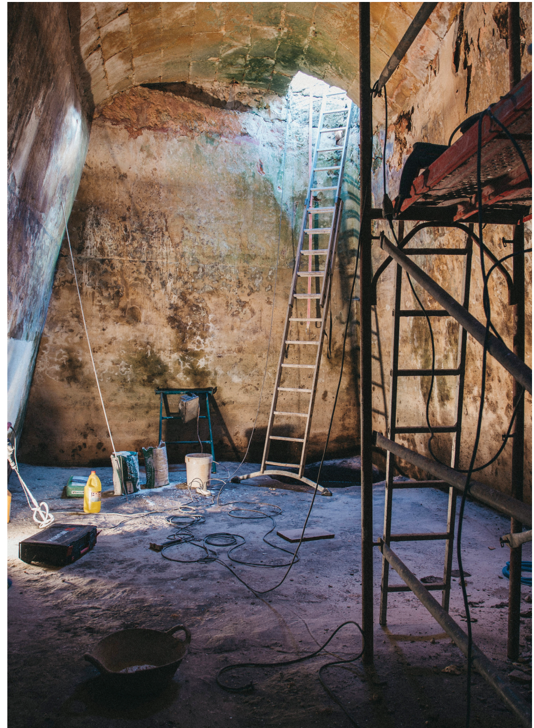
ANCIENNE CITERNE RÉHABILITÉE POUR STOCKER L'EAU
