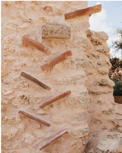
ÉVACUATION DES EAUX DE PLUIE EN TUILES RÉNOVÉES
