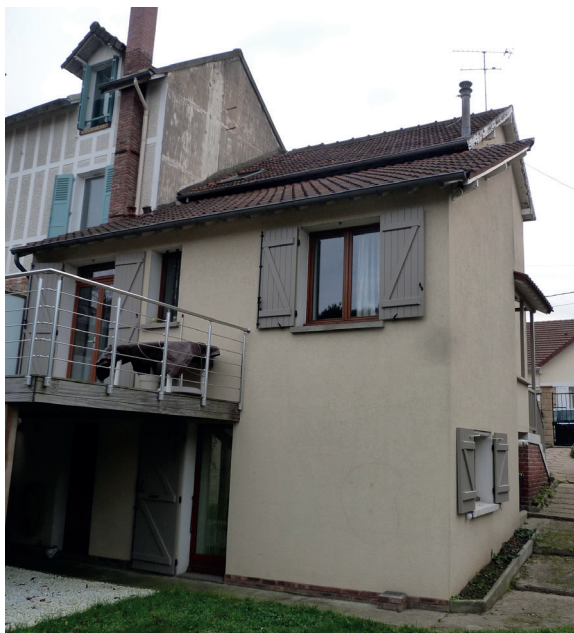
Le pavillon avant intervention
