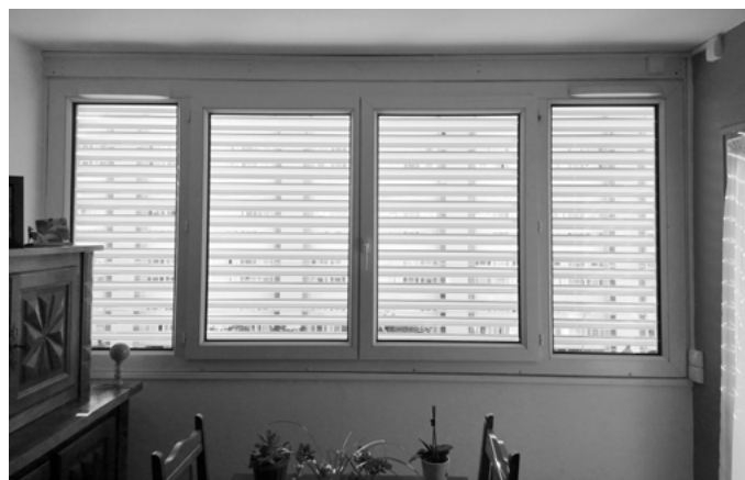
↑ Vue depuis l'intérieur d'un appartement : le brise soleil
