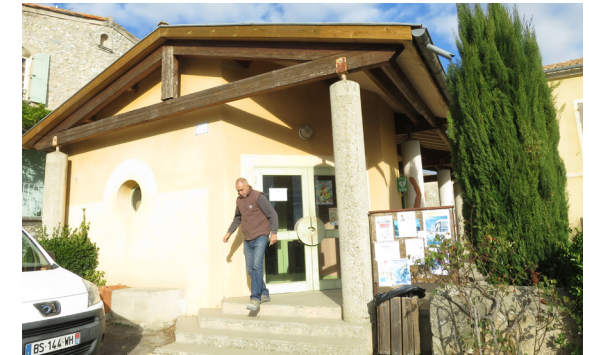
Facade Sud avant
