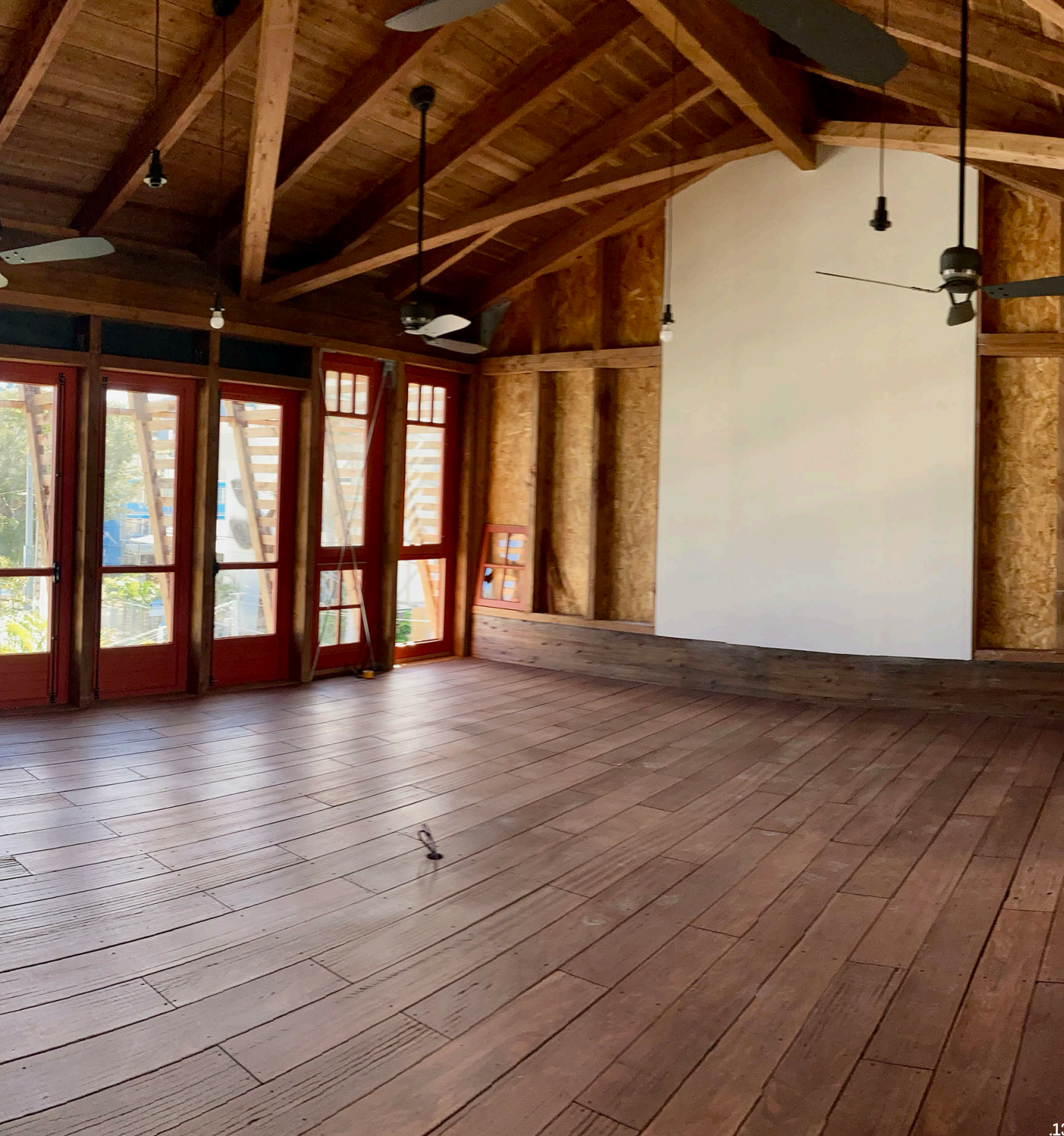
13. Plancher de la salle du conseil, lames du Pont de la Rivière de l'Est réemployées 14. Déconstruction du Pont de la Rivière de l'Est, gisement source 15. Raboutage des lames en Atelier par ASSELIN
