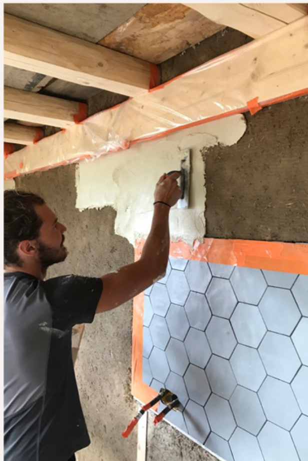
Mur en cours de réalisation
