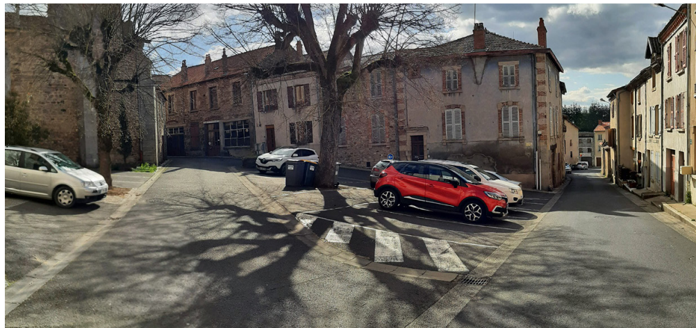
Vue de l'ensemble de la place Catherine Gired avant les travaux
